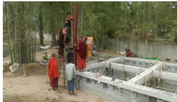
Unter Anleitung eines örtlichen Baumeisters und der Einbeziehung eines großen Teiles der Dorfbevölkerung wurden nach den Ausschachtungen Fundamente gemauert und die Bodenplatte gegossen.
